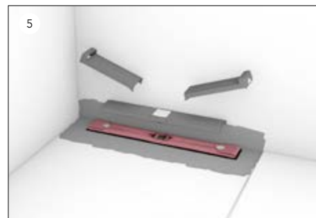
Nach dem Verfüllen mit Estrich wird der Bauzeitschutz entfernt, die erste Schicht der Verbundabdichtung aufgetragen...
